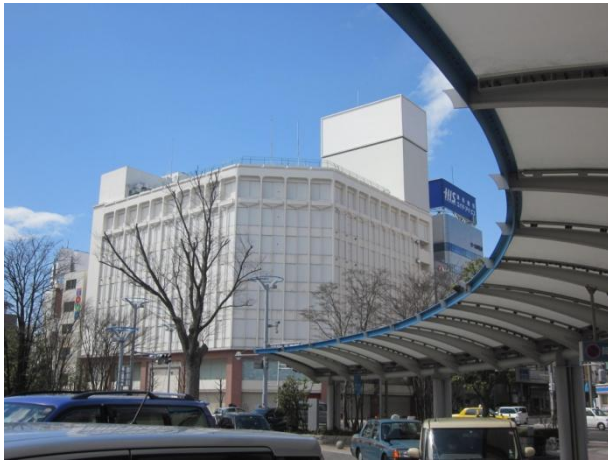
↑解体前の丸井郡山店跡地（2012年4月6日撮影）
