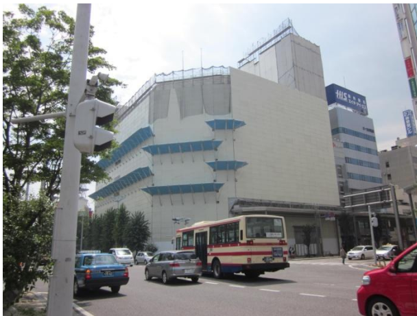
↑解体作業中の丸井郡山店跡地（2013年8月9日撮影）
